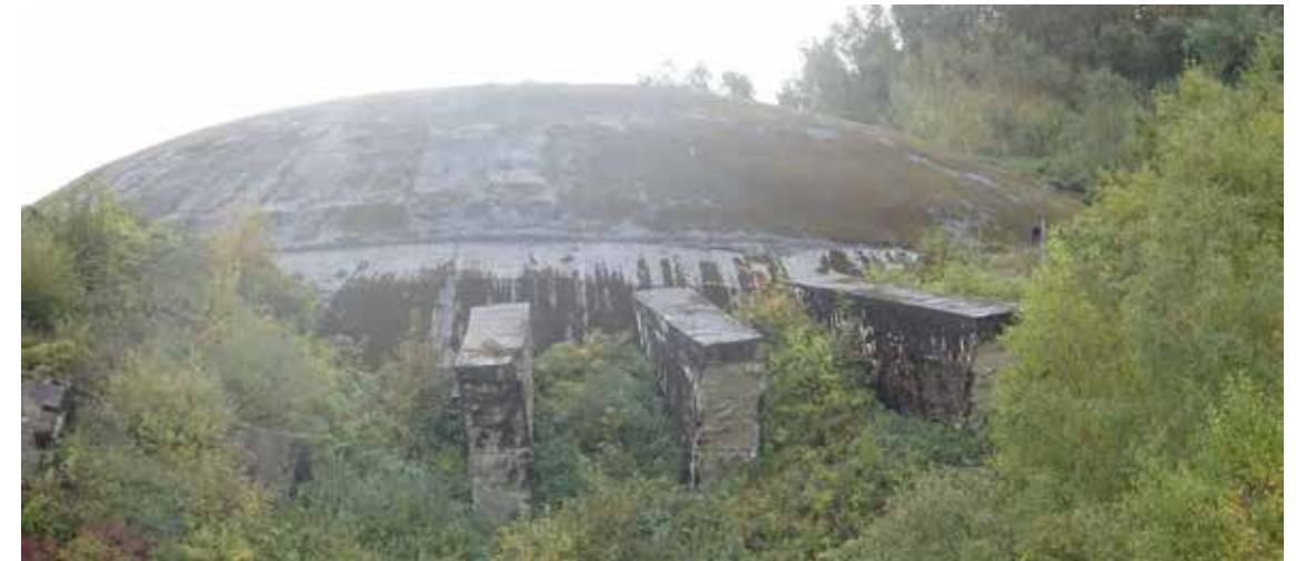
Der mehrere Stockwerke hohe ehemalige Raketenabschussbunker auf dem Höhenzug L'ancien bunker de lancement de missiles sur la crête de la colline The former rocket launch bunker on the ridge
